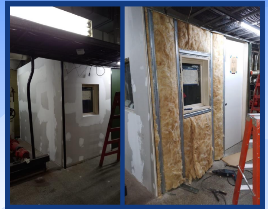
Acustización y pintura de oficina en sector climatización
