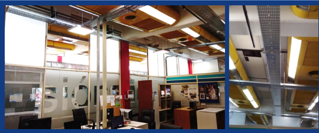
Área redacción: colocación de artefactos eléctricos
