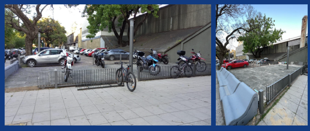
Colocación de baldosas en piso de ciclero
